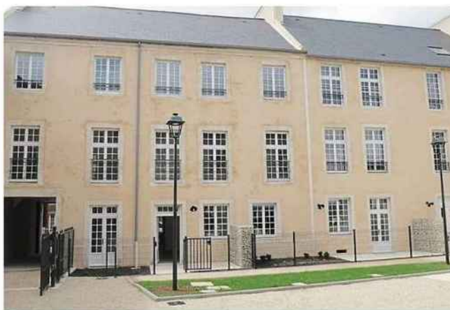
Dans cette bâtisse, rue des Bouchers, 11 logements seront livrés aux propriétaires à la fin du mois d'août.
