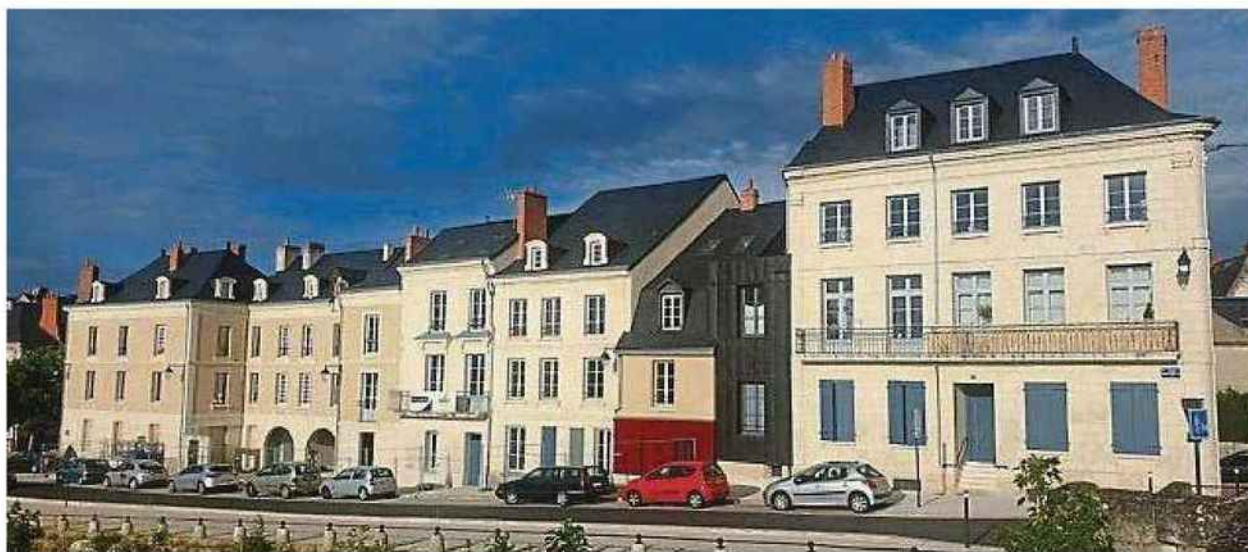
A Châtelleraut, sur l'îlot des Cordeliers, un programme Malraux de Buildinvest a été récemment livré. Photo Buildinvest
